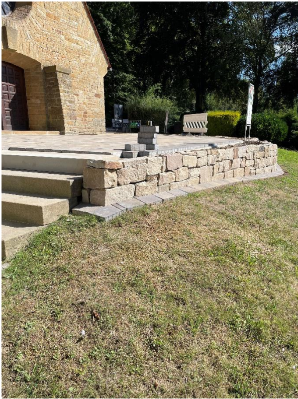
Trockenmauer am Treppenaufgang
